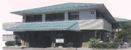
愛媛県障がい者更生センター
